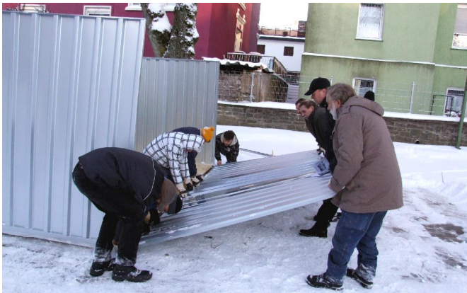
Aufbau der Container durch die Helfer des Arge-Projektes.
